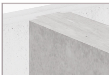
Gotowy zabetonowany łącznik ścienny.
