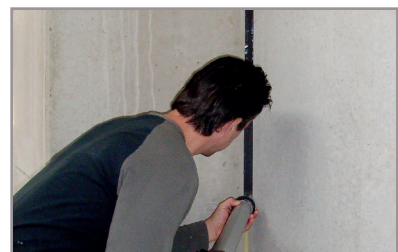
Brak konieczności gruntowania fugi
